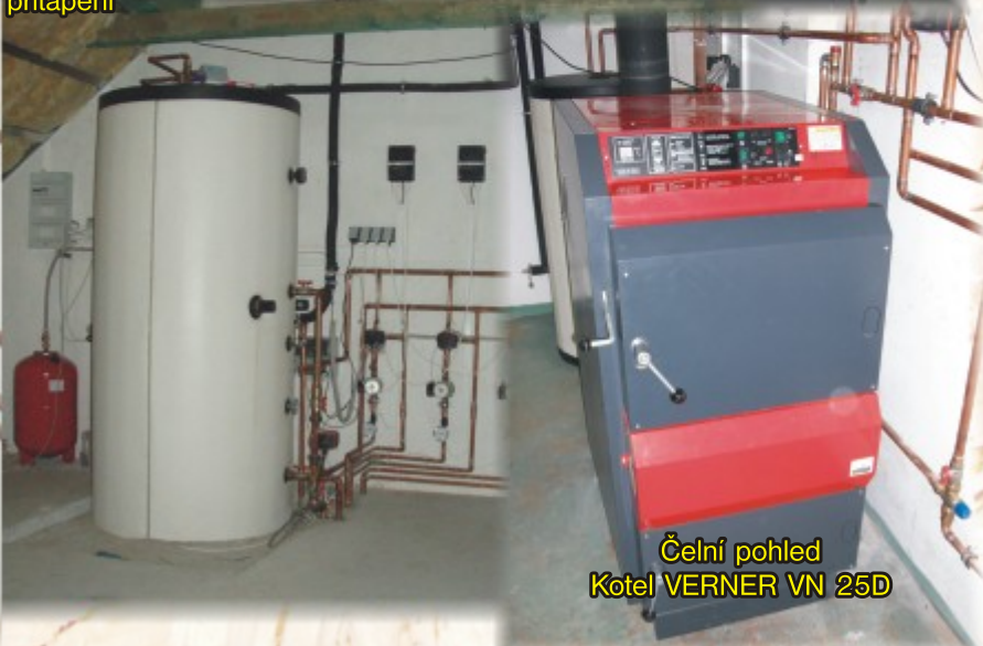
Kotel VERNER VN 45 v kombinaci s akumulací nádrží REGULUS a slunečními kolektory KPS 11 ALP pro přitápění
