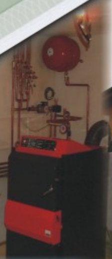
Nerezový kotel VERNER VN 25 D v kombinaci s elektrokotlem a kombinovaným ohřivačem teplé užitkové vody
